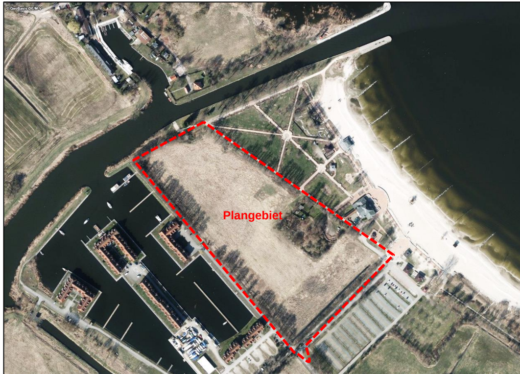
Luftbild (Quelle Geoportal MV)
