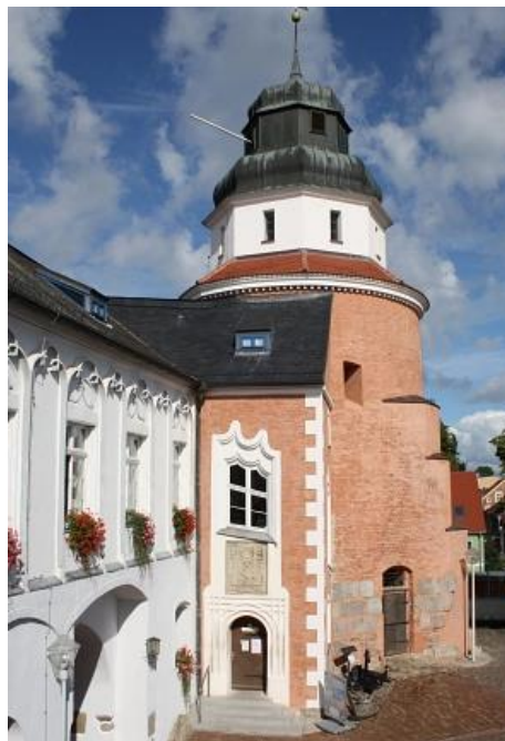
nach der Sanierung (Foto: Stadt Ueckermünde)
