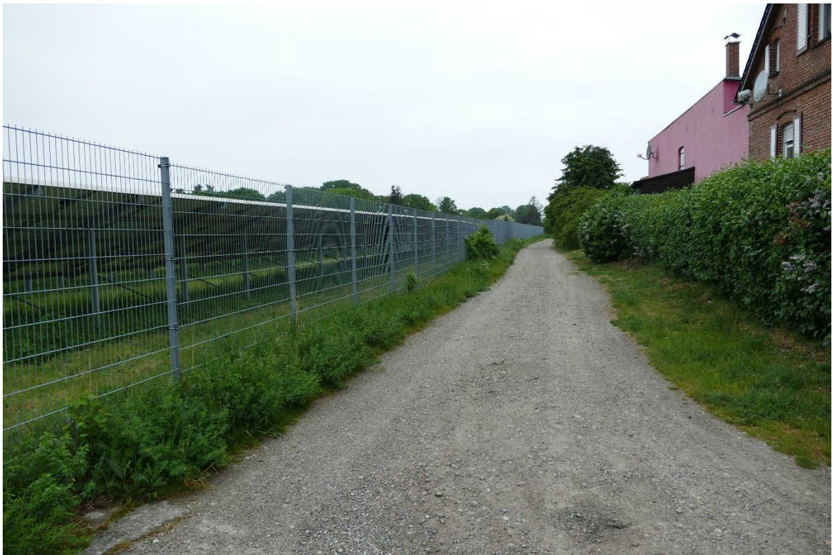
Bild 04 M2 Sichtschutzhecke 5 m nicht vorhanden (s. BP Nr. 27, 2012)
